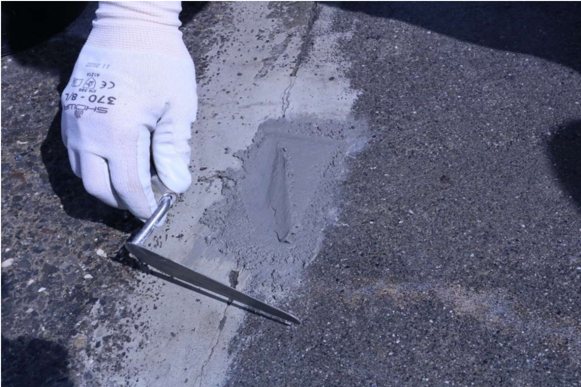
Glattstreichen des Betons
