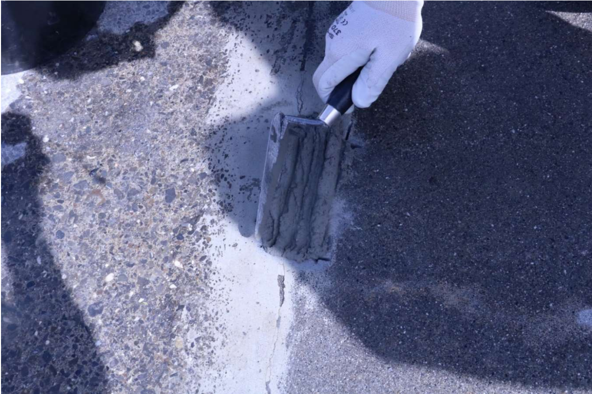
Beton verdichten, damit er besser hält
